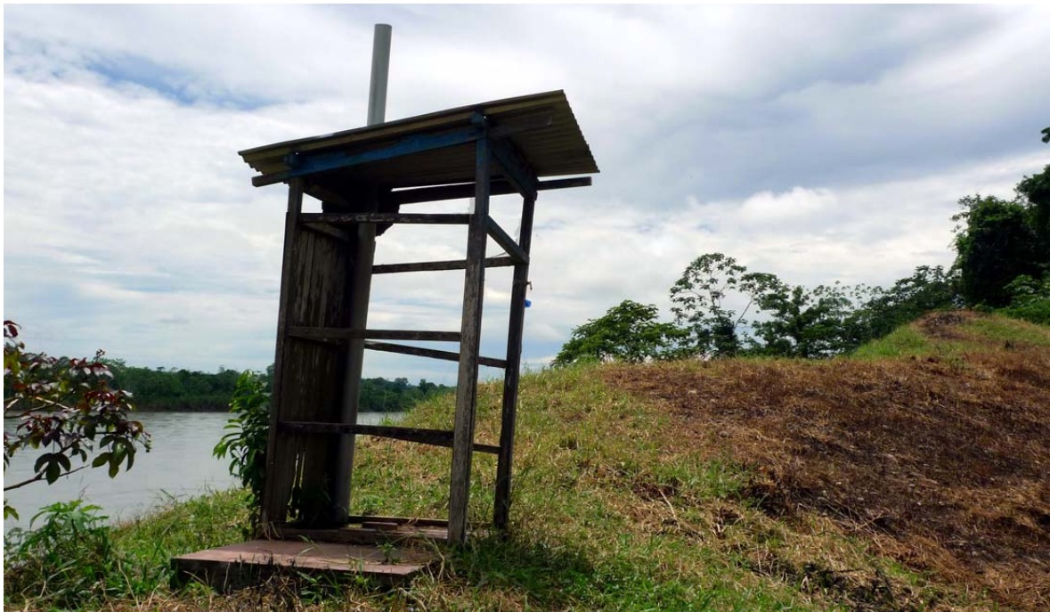
Fotografía B1.4.5 Lo que queda de una letrina ventilada de doble cámara en el Barrio de Santa Rosa. Autor: Gonzalo Muñoz Bartolomé.
