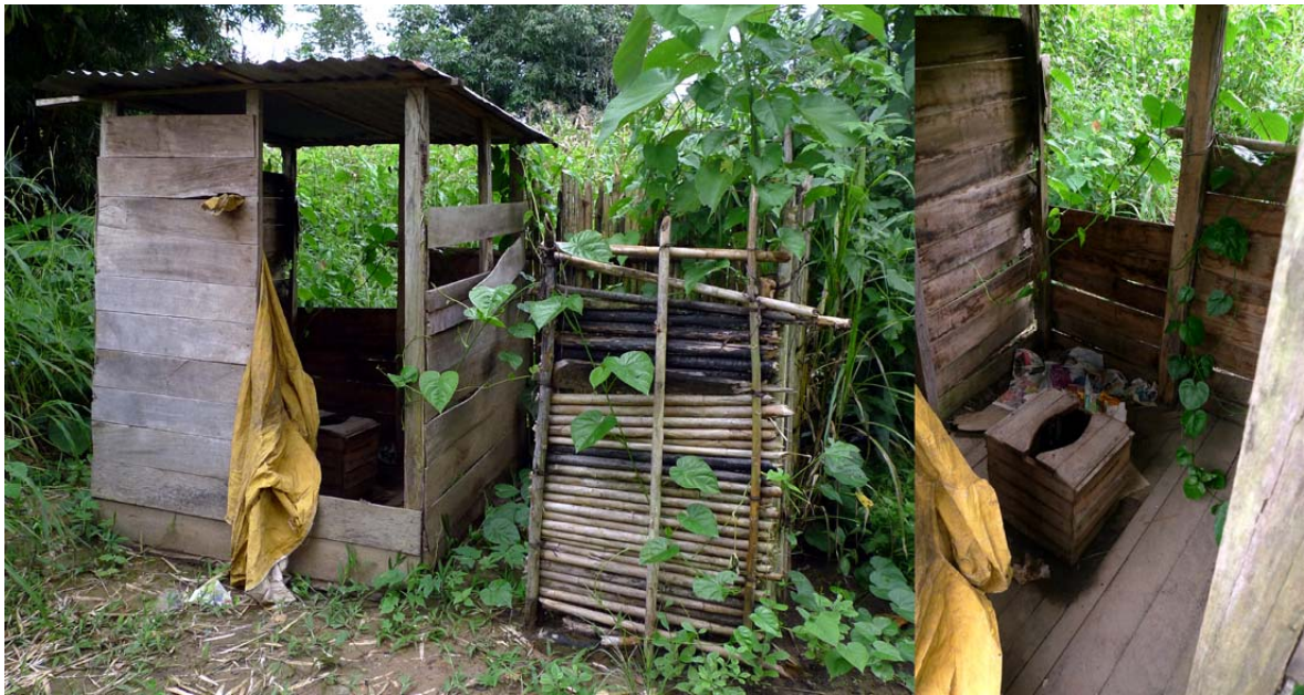
Fotografía B1.4.8 Doble letrina autoconstruida. Una con caseta y mejorada con asiento, la otra sin caseta en el Barrio de San Felipe. Autor: Gonzalo Muñoz Bartolomé.
