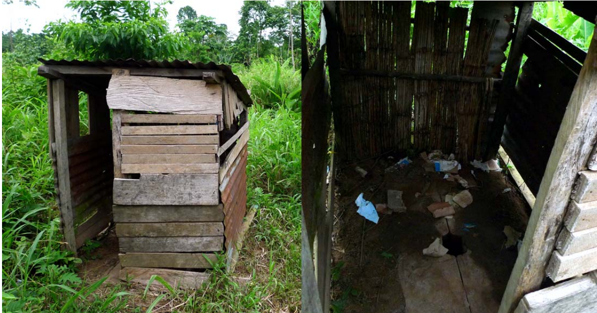
Fotografía C1.4 Letrina autoconstruida del Barrio de San Felipe. Autor: Gonzalo Muñoz Bartolomé.
