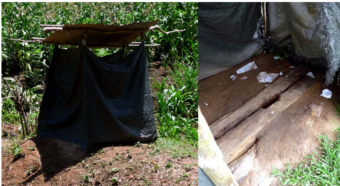
Fotografía B1.4.6 Letrina autoconstruida con caseta en el Barrio de San Felipe. Autor: Gonzalo Muñoz Bartolomé.
