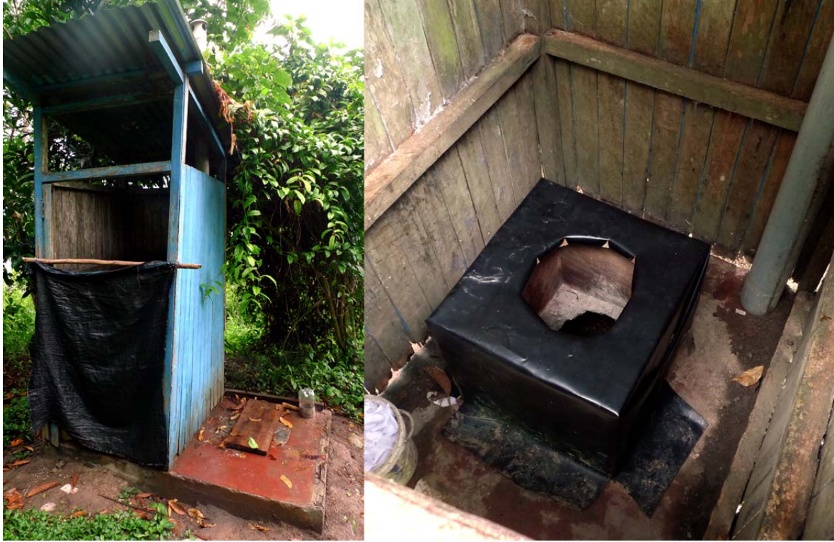
Fotografía B1.4.4 Mejoramiento con asiento de letrina ventilada de doble cámara en el Barrio de Santa Rosa. Autor: Gonzalo Muñoz Bartolomé.
