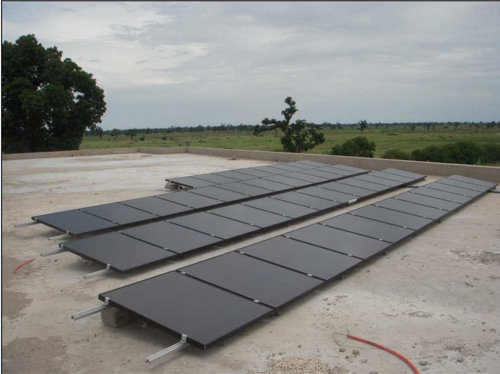
**Ilustración 18: Detalle de los paneles fotovoltaicos instalados en la cubierta del Centro Polivalente de Formación de Sandiara**
