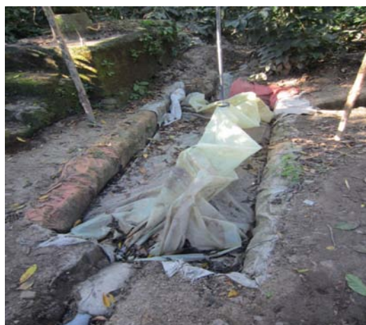
Fig. 9.23-. Biodigestor modelo Taiwán en desuso tras tres meses de instalado
