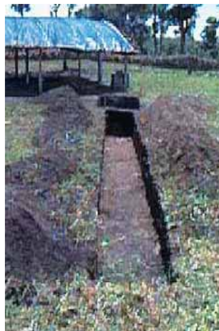
Fig. 9.30-. Zanjeo realizado por el beneficiario previo a la instalación del biodigestor Fuente: Elaboración propia
