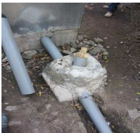
Fig. 9.22-. Modelo de letrina, salida de la letrina y entrada para otras materias primas (excrementos de animales o aguas mieles) conectada al biodigestor
