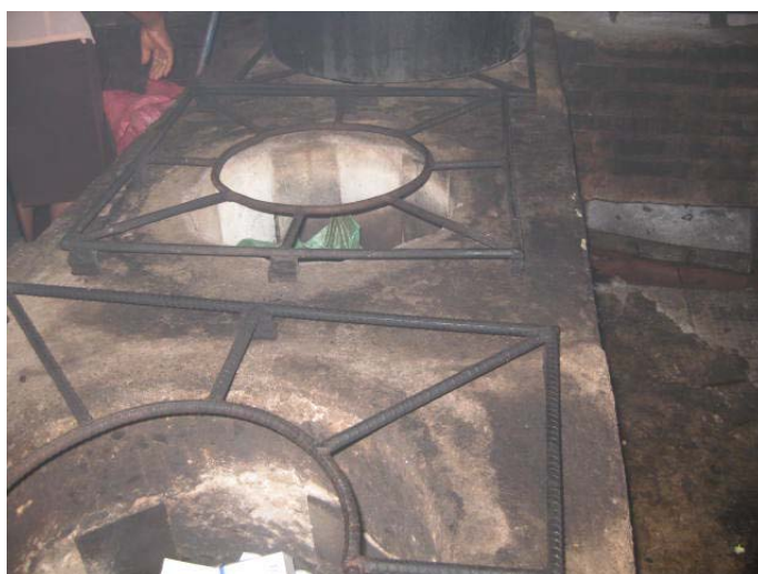
Fig. 9.36-. Cocinas peluseras modificadas por la propietaria para uso del comedor comunitario
