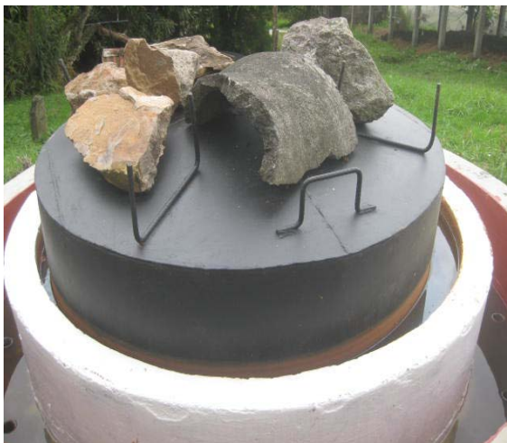
Fig. 9.38-. Biodigestor de estructura y cúpula fija con aguas mieles
