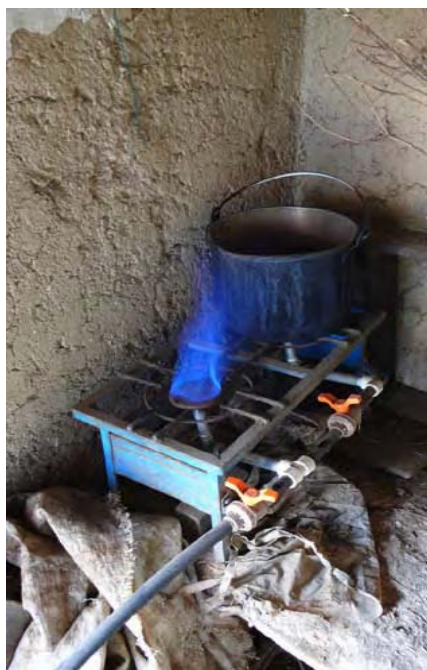
Fig. 9.29-. Cocina en funcionamiento con gas procedente del biodigestor Fuente: Elaboración propia
