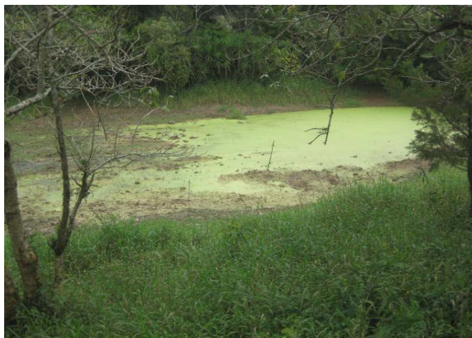
Fig. 9.39-. Laguna de tratamiento de las aguas efluentes de los biodigestores para su reutilización en riego de pastos
