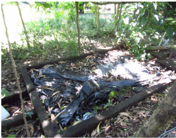
Fig. 9.25-. Biodigestor de estructura fija de cúpula flotante conectado a porqueriza en desuso tras 6 años de funcionamiento.
