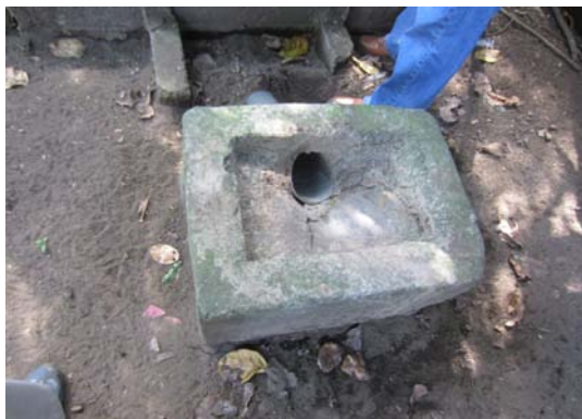
Fig. 9.27-. Cámara de entrada al biodigestor
