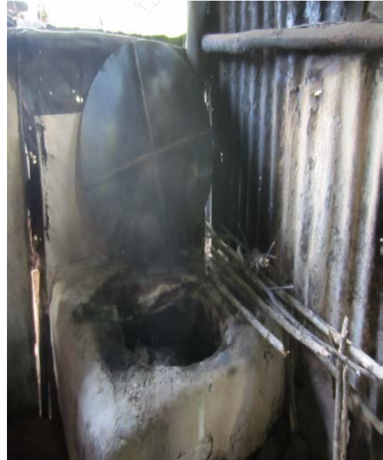
Fig. 9.6-. Cocina pelusera de creación propia por los usuarios Fuente: Elaboración propia
